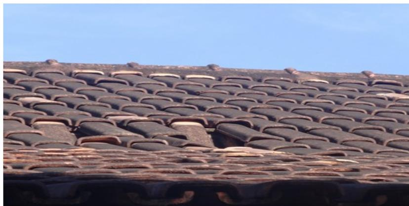
**(Vista do telhado cedendo em função das ruptura das peças de madeira de sustentação do mesmo)**
