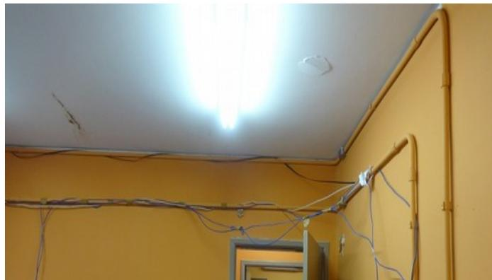
**(Fiação da rede lógica instalada de forma improvisada)**
