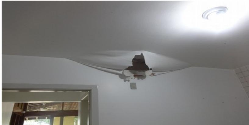
(Pintura danificada em função da infiltração na copa)
