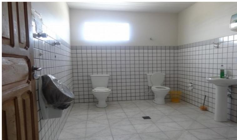
(Conjunto de sanitários masculino, de uso comum da DGH, DRRFVAT e DRCASP. Mictório e bacia sanitária interditados e ausência de divisórias sanitárias)
