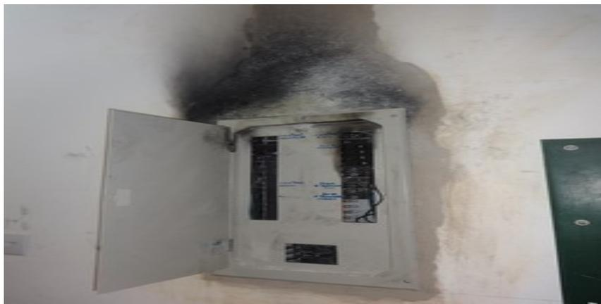
**(Corredor da DDIJ. Parede com pintura danificada por curto circuito em Quadro de Distribuição da rede elétrica)**
