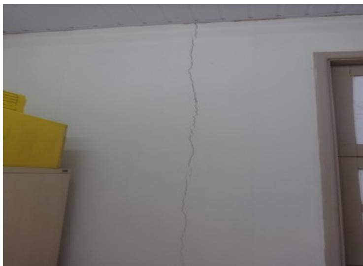
(Trinca em parede)
